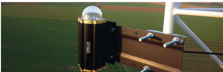
Balise Basse Intensité, installée sur un mât de mesure.
